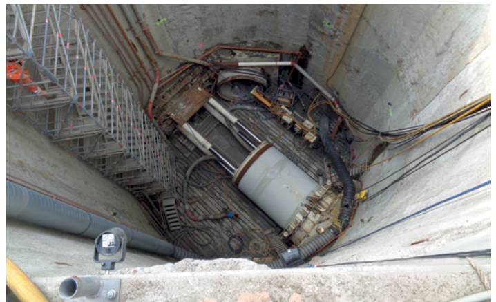
Startschacht mit Schlitzwandverbau und Ausfahrdichtung für Wasserdruck von mehr als 2 bar
