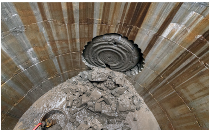
Einfahrt aus Fels in Spritzbeton-Zielschacht
