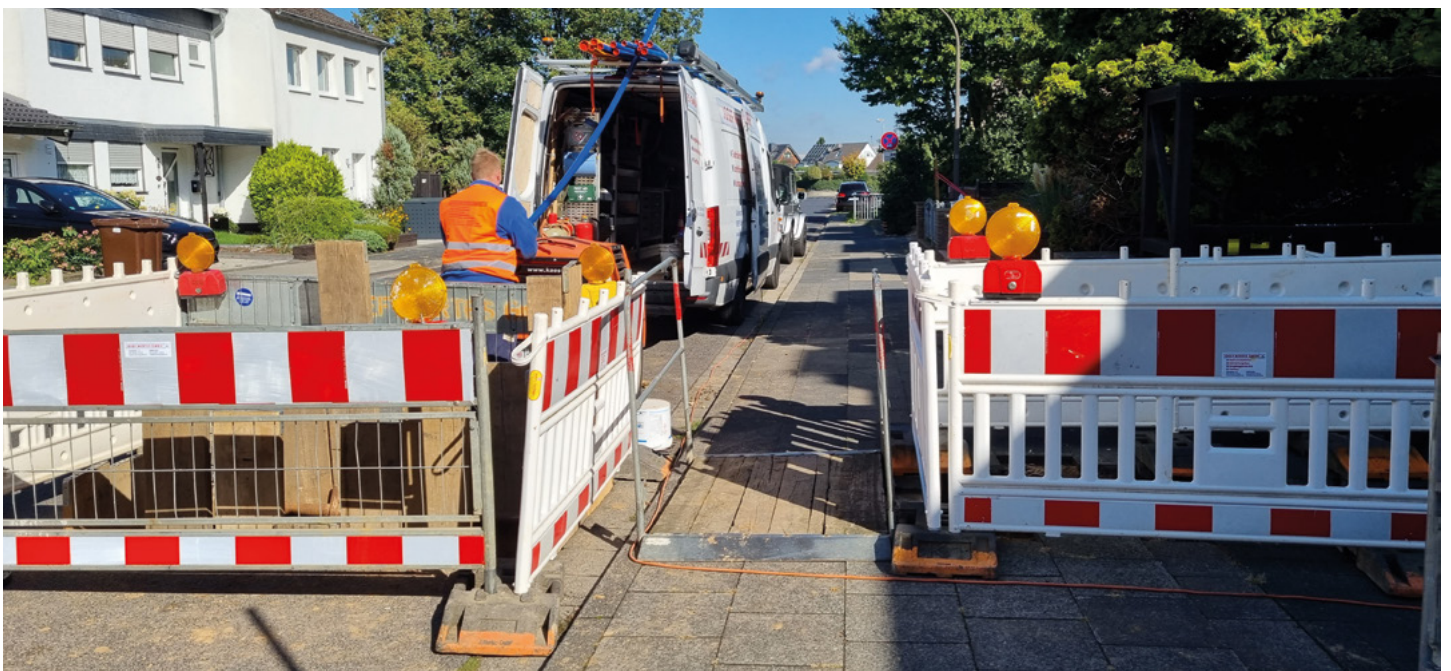
Bild 10: Baustelle mit einer Grabenbrücke.
