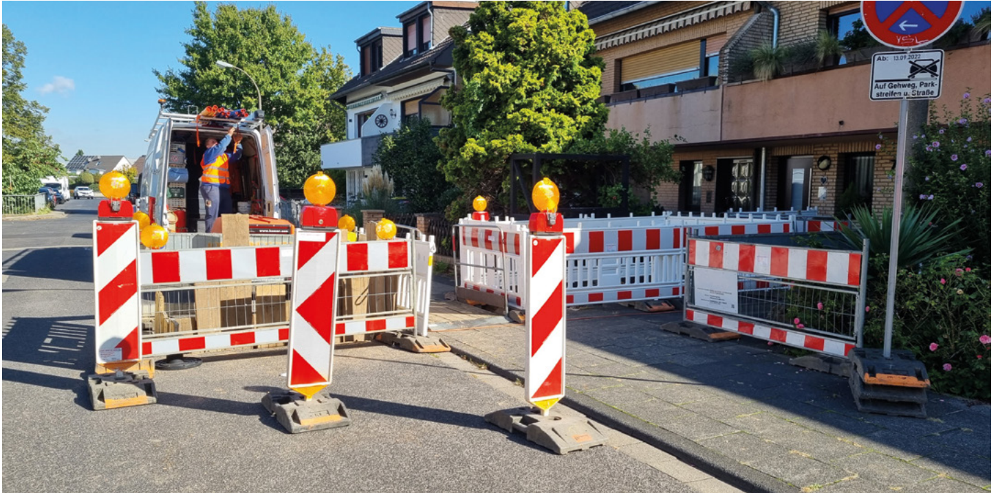
Bild 13: Absicherung einer Hausanschlussbaustelle nach der RSA 21.
